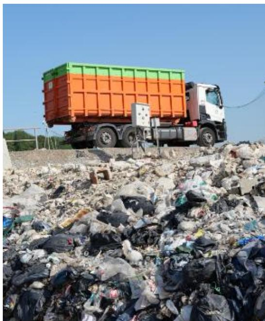
Ce centre d'enfouissement peut accueillir 80 000 tonnes de déchets résiduels par an. Les ordures ménagères résiduelles, les refus de tri et les encombrants du territoire y sont stockés dans des alvéoles étanchéifiées par une barrière passive (imperméabilité du sous-sol) et une barrière active (géomembranes).
