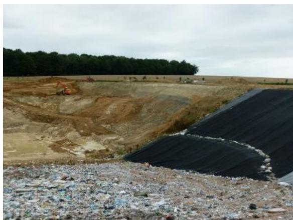
Une fois les alvéoles couvertes, les déchets qu'elles contiennent produisent du biogaz. Ce biogaz produit par les déchets en décomposition et récupéré via des canalisations et valorisé en énergie (électricité et chaleur) dont une partie est utilisée pour le fonctionnement du site et l'autre partie réinjectée sur le réseau EDF (l'équivalent des besoins annuels moyens en électricité des près de 775 foyers).
