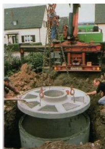
Installation d'une citerne enterrée
