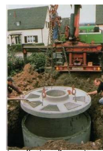
Installation d'une citerne enterrée
