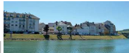
Front urbain sur le quai Galbraith, de la séquence historique à du petit collectif du XXe siècle
