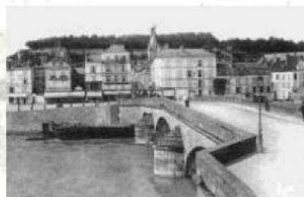
Le pont de la Marne reconstruit
