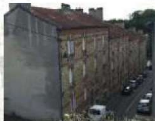
Cité ouvrière rue du Parc
